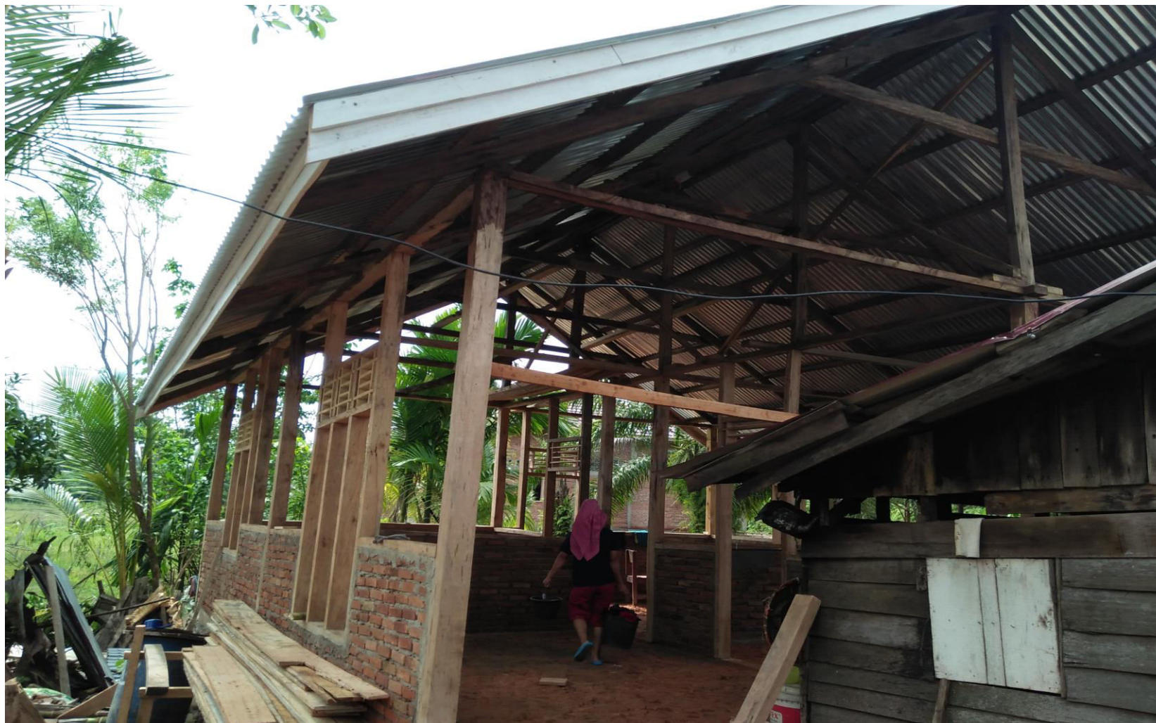
Tahap pekerjaan pasangan dinding dan pekerjaan atap
