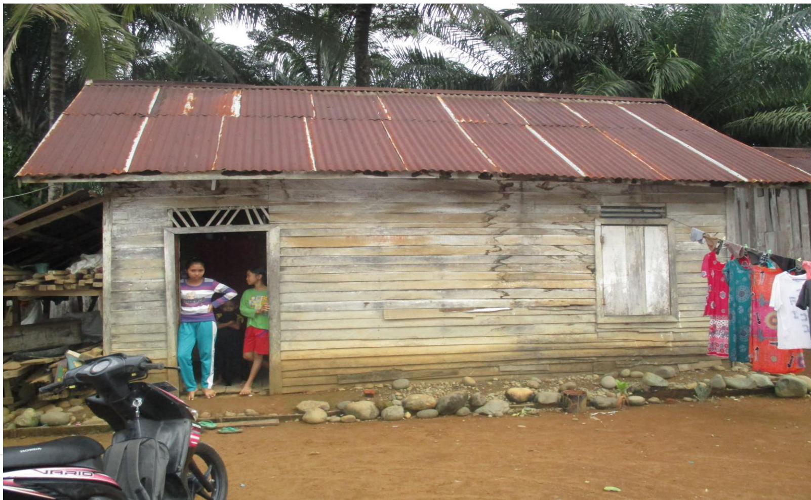
Tampak Kondisi Rumah Sebelum Direnovasi.
