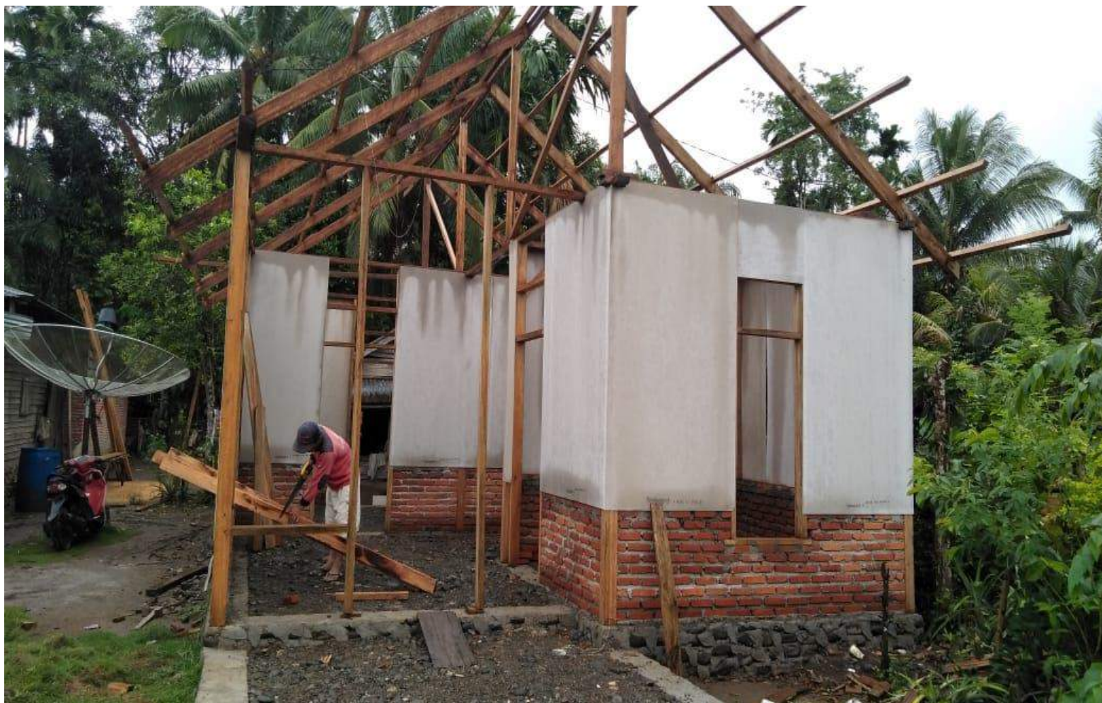
Pekerjaan Dinding dan Kuda-kuda Atap
