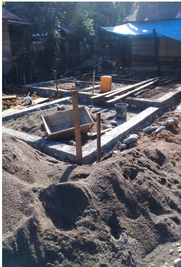
Tahap pekerjaan Pasangan Pondasi dan timbunan pondasi.
