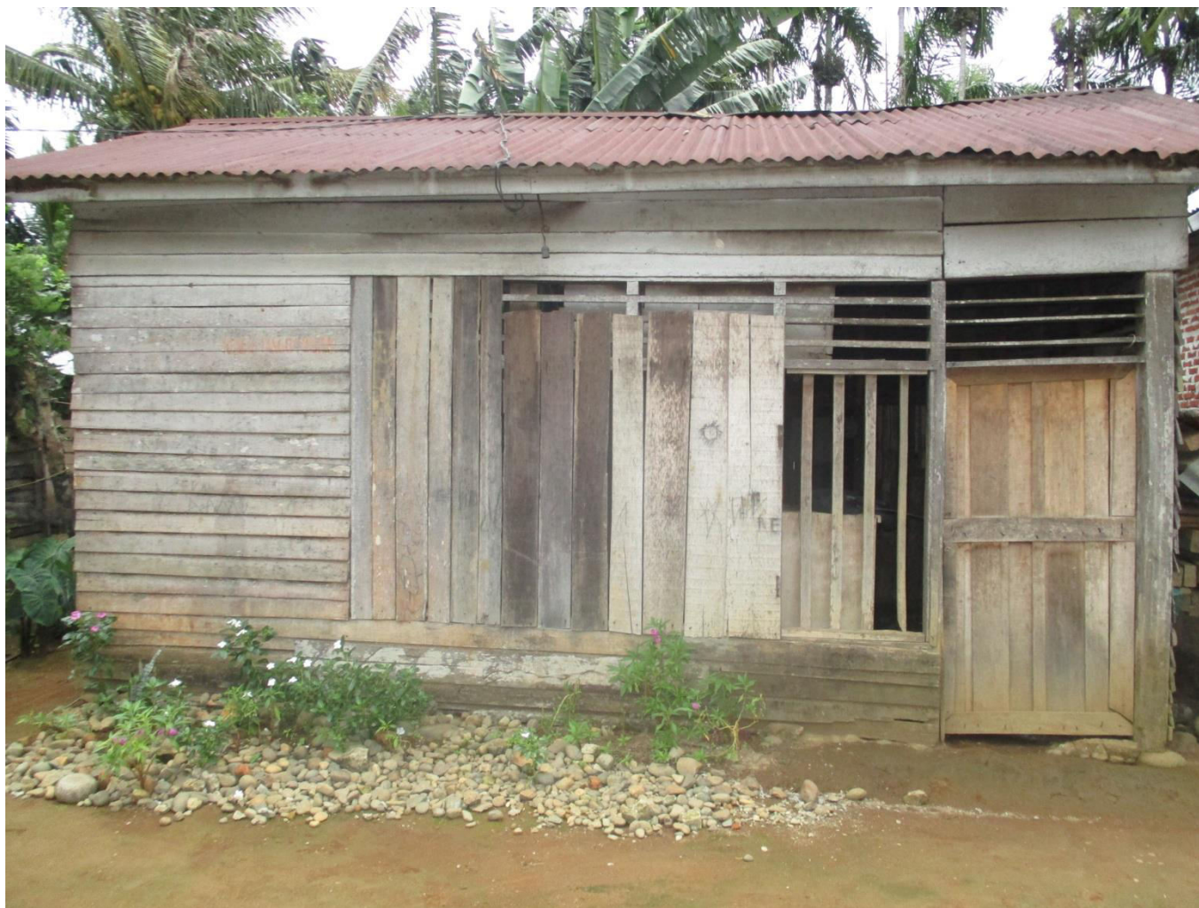
Foto Keadaan Sebelum Direnovasi.
