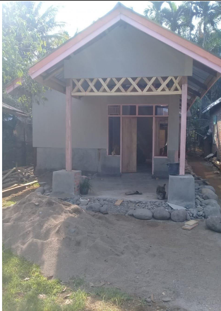
Pekerjaan Selesai dan Siap Huni.
